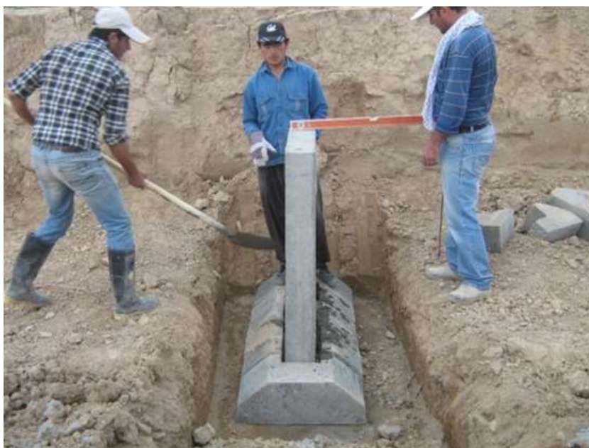
شکل (۵-۶): نصب پایه درون کفشک
