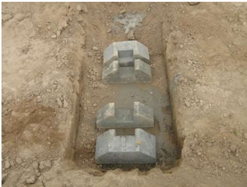
شکل (۵-۵): نصب کفشک
