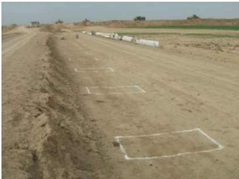
شکل (۵-۲): گچ‌ریزی جهت پی‌کنی محل نصب کفشک‌ها
