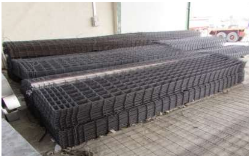
شکل (۲-۵) شبکه میلگرد جوش شده (مش)
