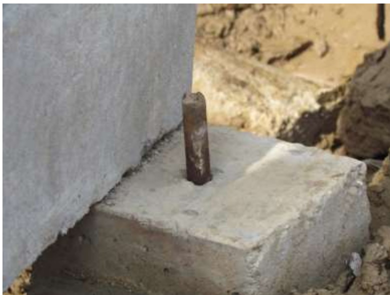
شکل (۵-۸): میلگرد اتصال زین به پایه
