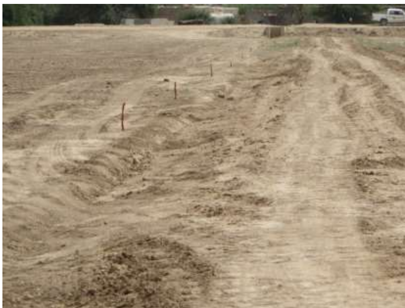
شکل (۵-۱): رگلاژ مسیر و پیکتاژ آن
