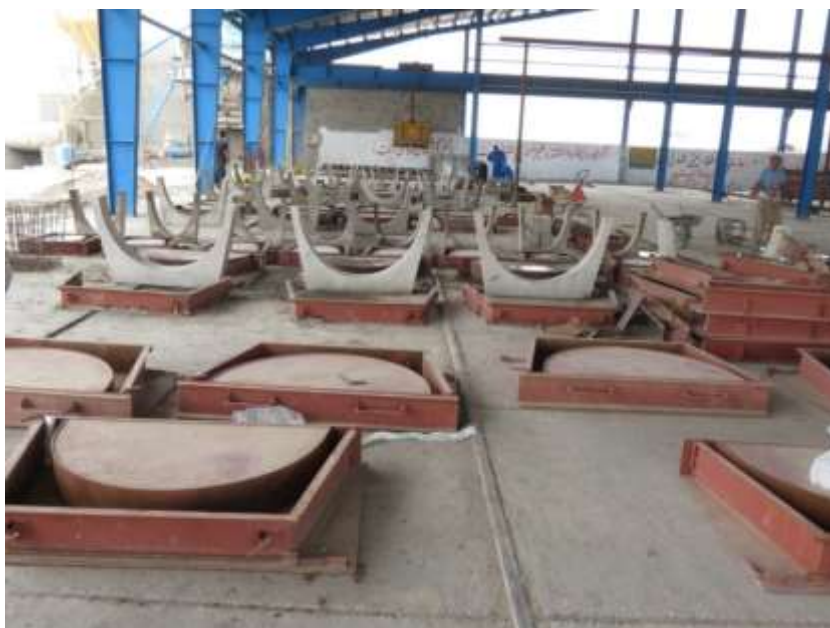
شکل (۳-۱۴): قالب ساخت و بتن‌ریزی زین‌ها
