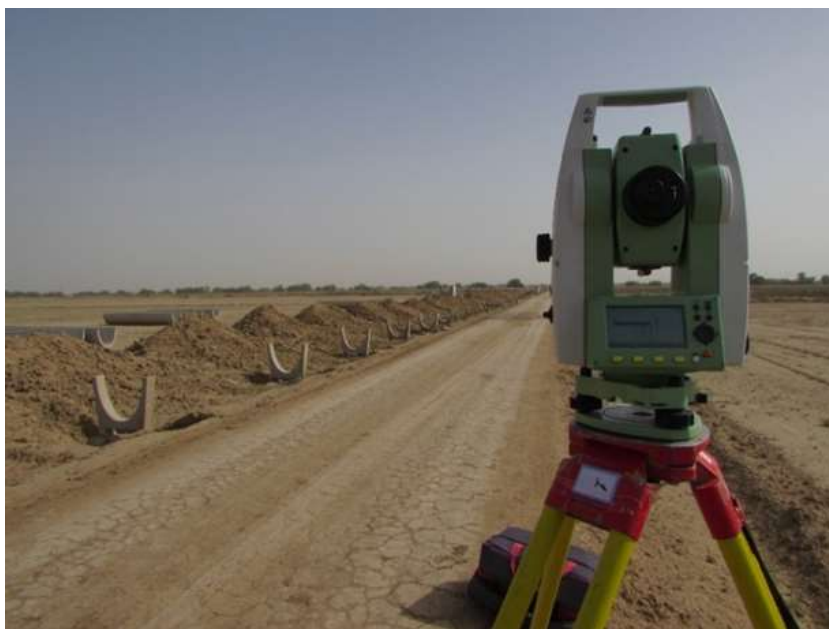
شکل (۵-۷): کنترل محور طولی و عرضی مسیر به کمک دوربین توتال استیشن
