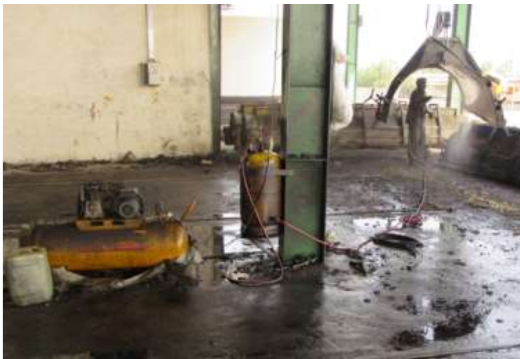
شکل (۳-۱): روغنکاری قالب بیرونی کانالت
