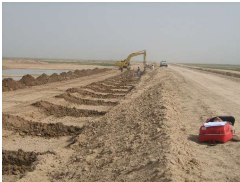
شکل (۵-۳): پی‌کنی محل با بیل مکانیکی
