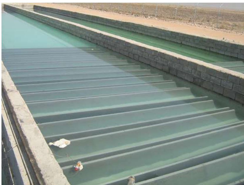
شکل (۴-۲): عمل آوردن کانالت‌ها در استخر آب
