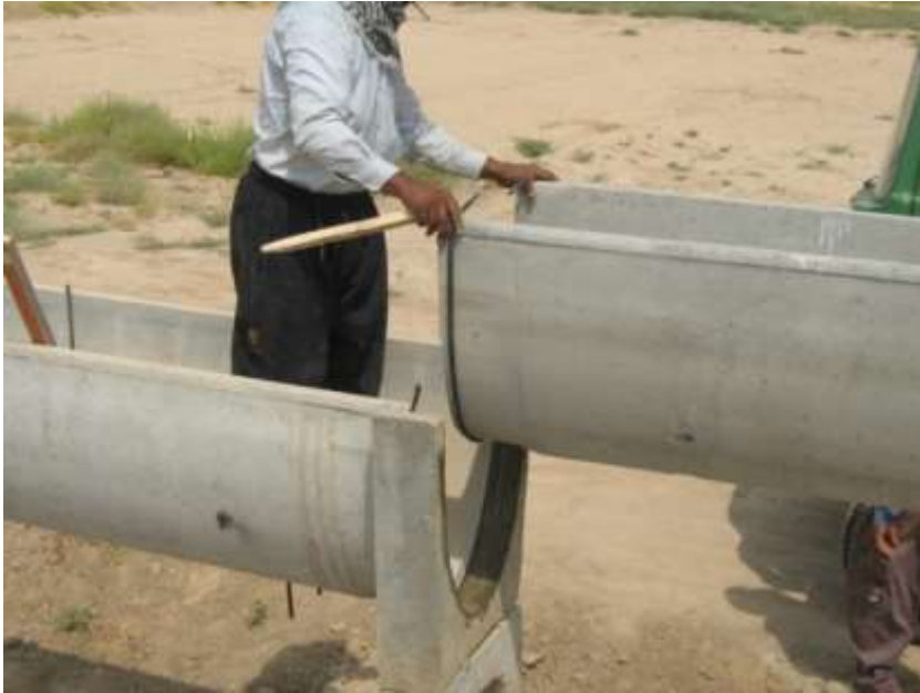
شکل (۵-۹): نصب نیم‌لوله بر روی زین
